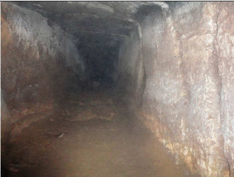
Galleria di Servizio dell'acquedotto Acqua Marcia (144-140 A.C.) di collegamento con la Maremmana inferiore, lunghezza circa 300 m
